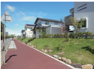
図5 外周ゴムチップ舗装
