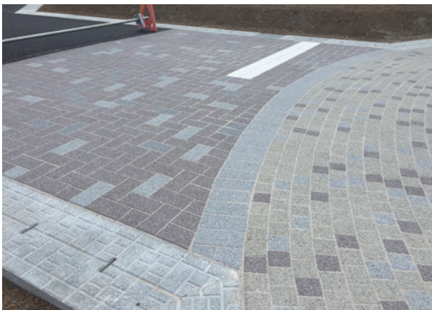
図3 保水性舗装による微気候デザイン
