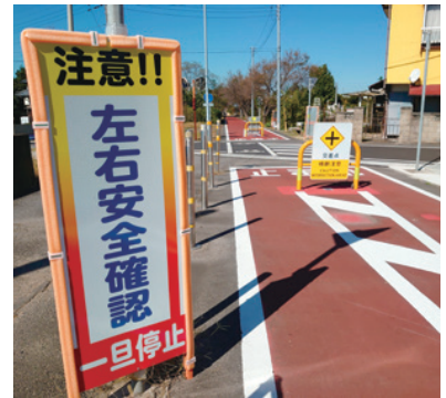
図6 自転車歩行者専用道路と一般道路との交差箇所は事故の危険性が高いため、より注意を引く看板が設置されている
