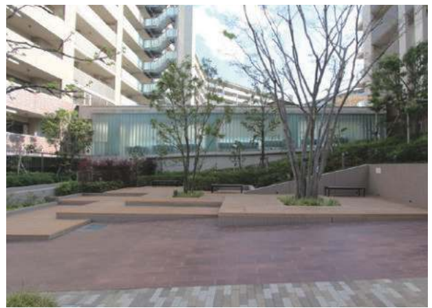
図4 勾配部に設置されたウッドデッキの階段はベンチとしても利用可能(撮影:宇都宮海氏)
